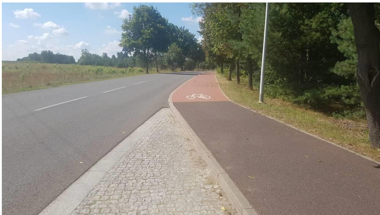
Fotografia 9 Droga rowerowa z Kleszczowa do Sulmierzyc
