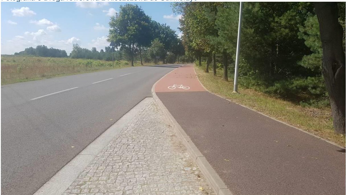
Fotografia 6 Droga rowerowa z Kleszczowa do Sulmierzyc
